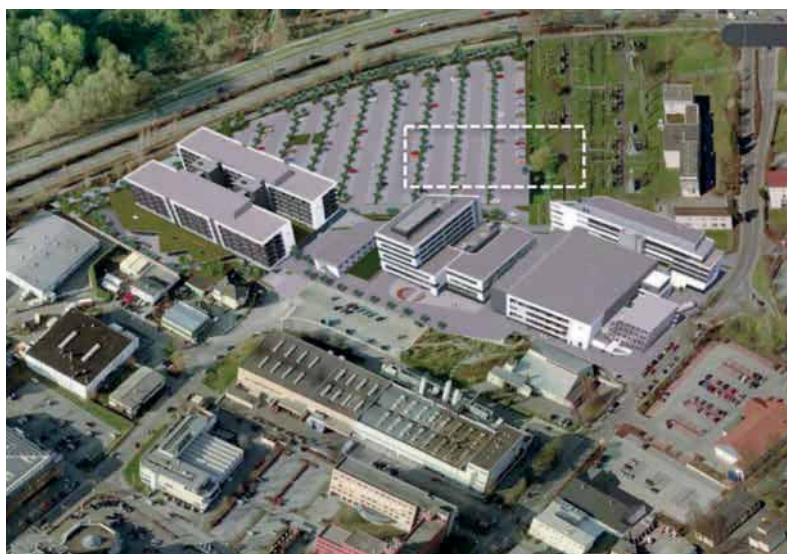
Nördlich der bisherigen Gebäude (gestrichelte weiße Linie) wird Vetter für 200 Millionen Euro ein weiteres Produktionsgebäude an der Ulmer Straße bauen.
