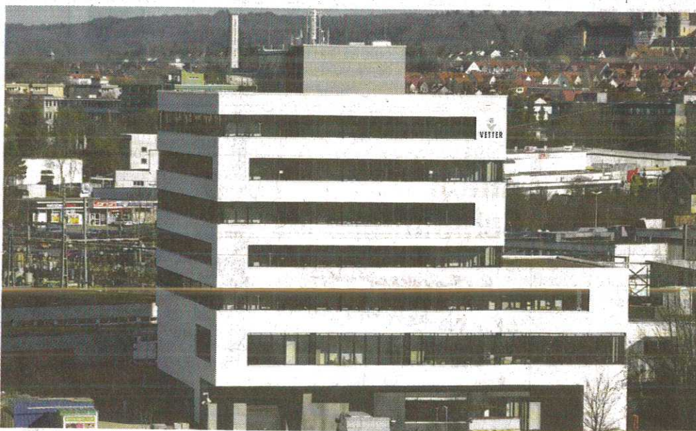
Das fertiggestellte Multifunktionsgebäude in der Ravensburger Schützenstraße
