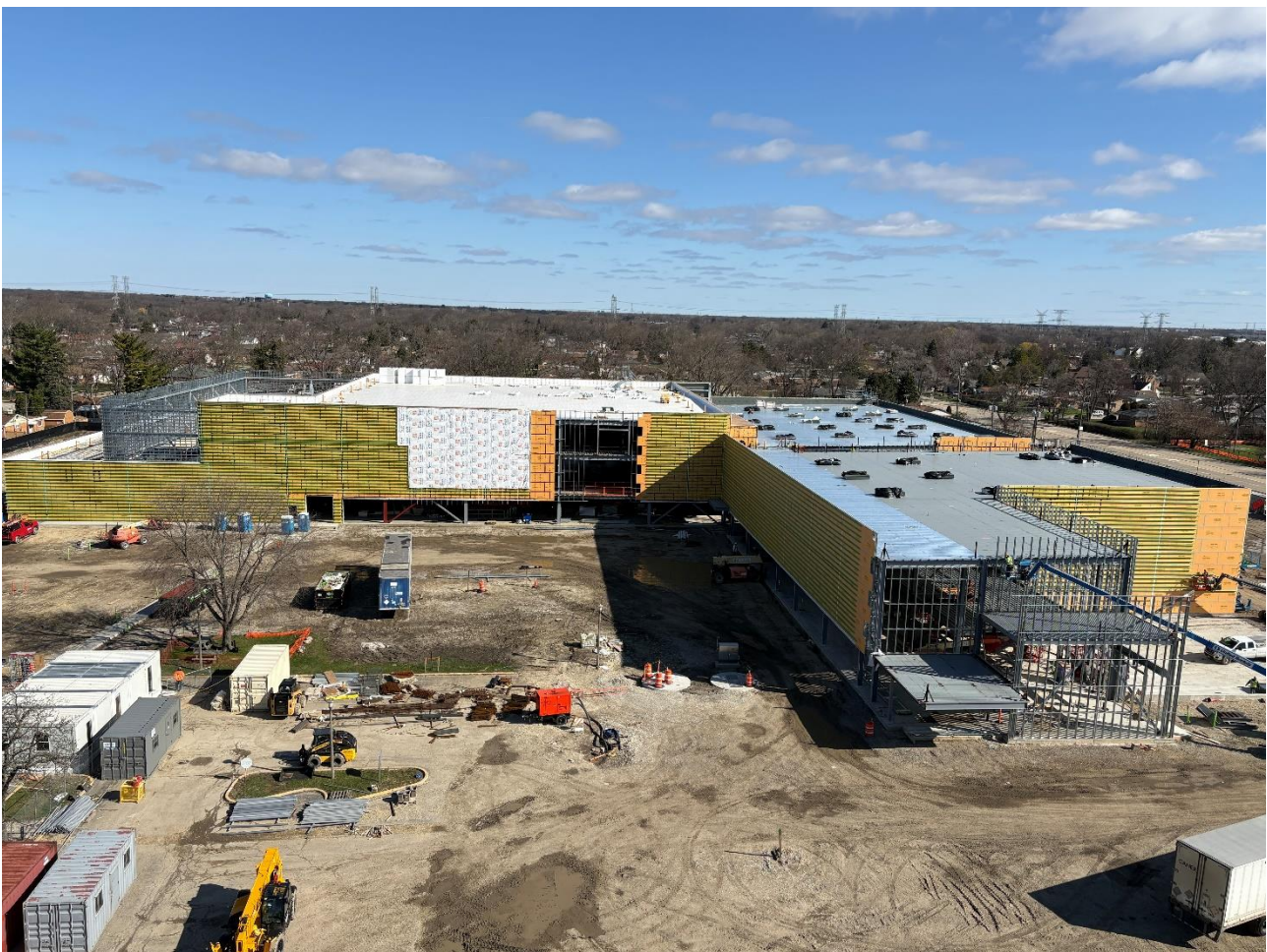
©Vetter Pharma International GmbH: Die Bauarbeiten auf der Vetter-Baustelle in Des Plaines schreiten planmäßig voran (April 2026)
