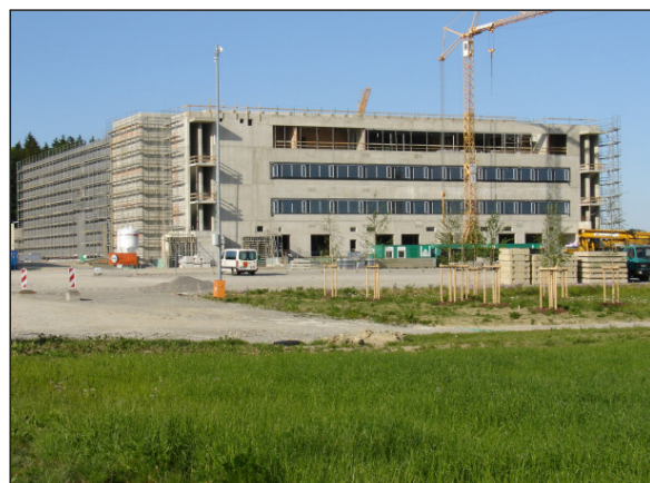
Im Rohbau fertig: das hochmoderne Zentrum für Optische Kontrolle und Logistik von Vetter im Gewerbegebiet Erlen
